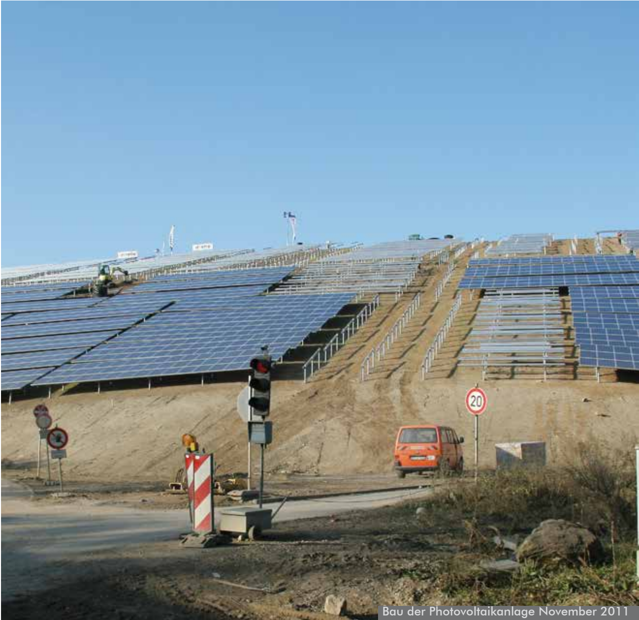
Bau der Photovoltaikanlage November 2011
